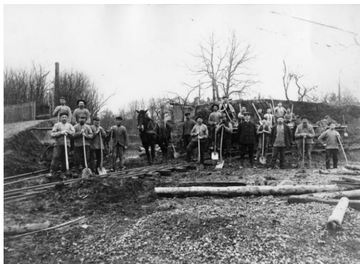
Ansatte hos Hans Jørgensen & søn i gang med at fjerne resterne af ringvolden
